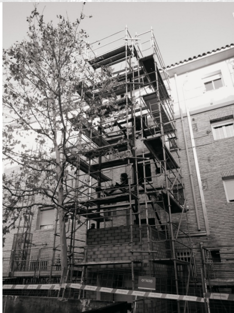
Edificio en obras en Grupo A. Rojas 21-22-23, que se visitará
